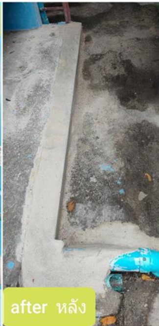
ปรับปรุงการวางท่อน้ำ
