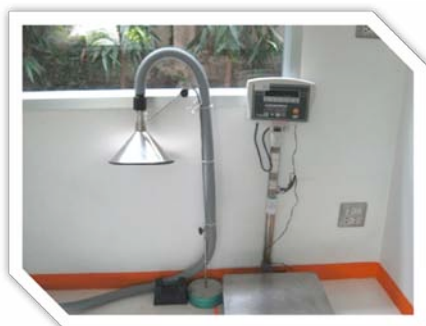
รูปที่ 4-3 ตัวอย่างระบบระบายอากาศเฉพาะที่ในห้องปฏิบัติการ
